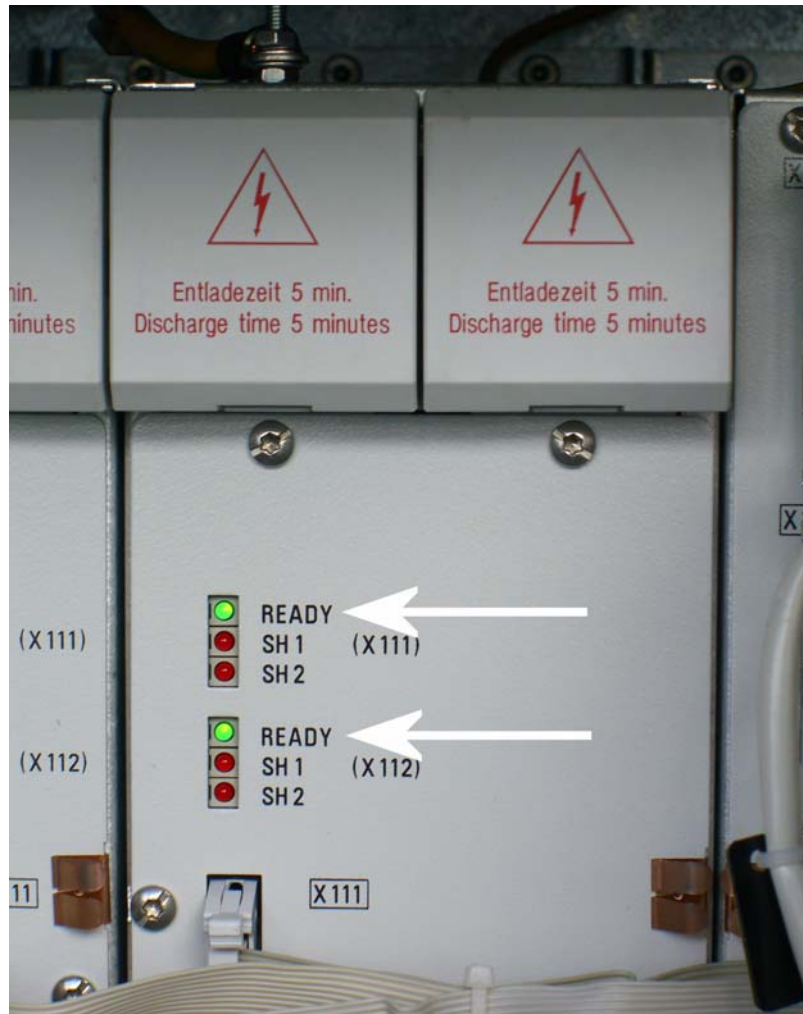
Photo: Green LEDs on the UM 121 B power module
